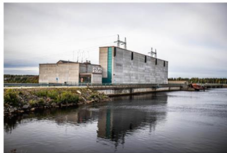
Maanantainen päättö ei vielä tarkoita kalateiden rakennustöitä. Kemijoki Oy:stä kerrotaan.
