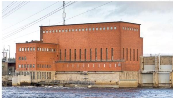
Pohjojan Voiman omistama Isohaaran voimalaitos Kemijoen alkupäässä.
